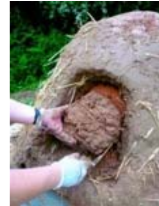
4) Cut out a door
